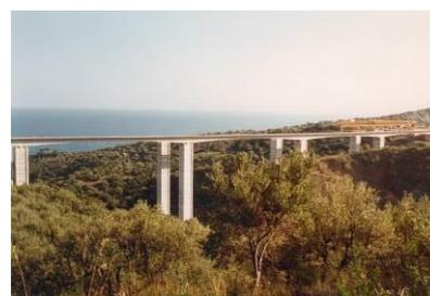
Viadotto Carbone: è composto da 2 travi continue di 5 campate da 100 m di luce ciascuna, con tracciato planimetrico completamente in curva avente raggio minimo di m 1560.
