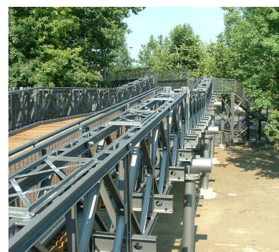
Le passerelle, complete delle rampe di accesso conformi alle normative per i portatori di handicap, hanno una lunghezza in asse rispettivamente di metri 97 (Corso Regina Margherita) e metri 135 (Corso Unità d'Italia).
