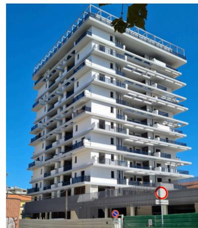
L'edificio in oggetto è stato progettato considerando un comportamento non dissipativo sotto le azioni sismiche: nella valutazione della domanda derivante dal sisma e della capacità dei singoli elementi, valutazione della domanda derivante dal sisma e della capacità dei singoli elementi, tutte le membrature sono quindi state progettate in campo sostanzialmente elastico.
