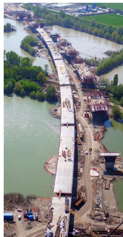
Il viadotto è completato da pile in c.a. e fondate su plinti che poggiano su pali. Le pile presentano sezione scatolare e altezza variabile.
