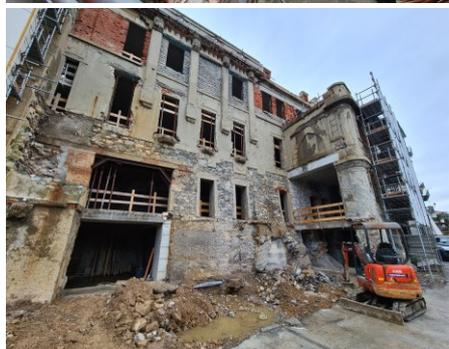
Prima dei lavori la struttura della locanda si presentava in forti condizioni di degrado sia dal punto di vista strutturale, che paesaggistico. I decori erano ormai compromessi e costituivano, insieme ai cornicioni, un pericolo per la pubblica incolumità per il rischio di crolli localizzati.
